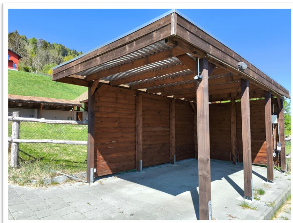
Autounterstand mit Stromanschluss
